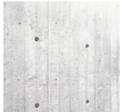
*Durch raue Schalbretter entstandene Betonoberfläche*
