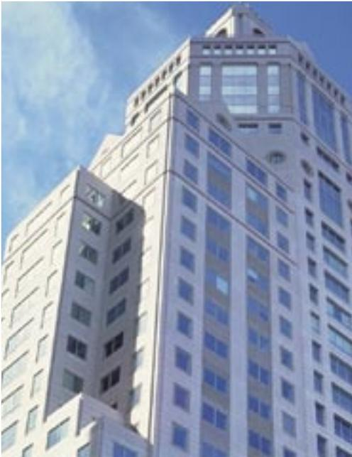
Weißer Beton ist ein Synonym für Licht, klare Farben und schöne, gleichmäßige Oberflächen – an Gebäuden jeder Größe ebenso wie an Einrichtungen aller Art. Mit weißem Beton erbaute Konstruktionen sehen automatisch eleganter und schlanker aus.
